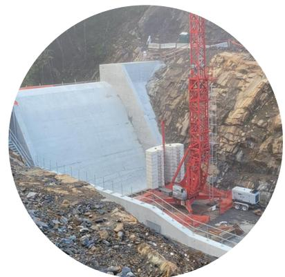
Meilleures pratiques en matière de sécurité des barrages : le barrage a été conçu pour être entièrement submergé lors d'un événement de crue.
